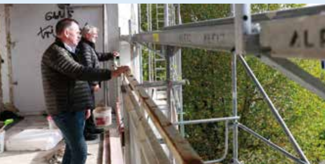
Traumhafter Ausblick von großen Balkonen: Zurzeit noch im Bau, können sich die künftigen Mieter in der Langfuhrstraße ab März 2020 auf moderne Wohnungen mit effizienter Wärme von Energie SaarLorLux freuen.
